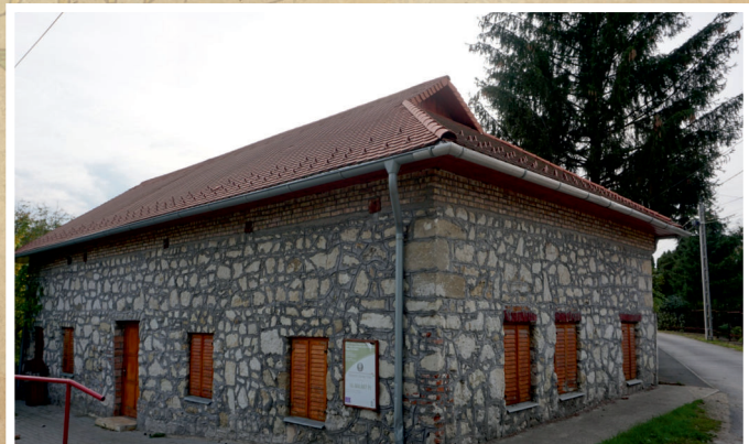
Malom felújított épülete
